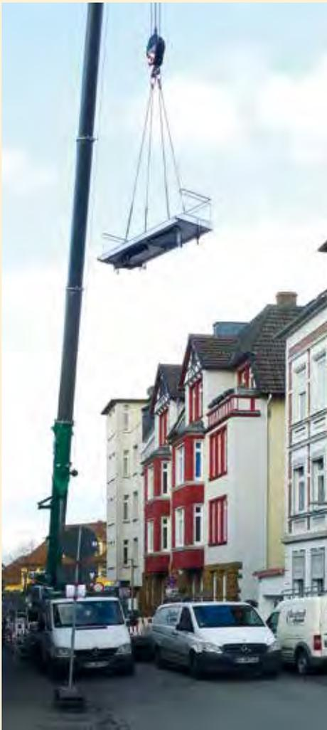
Eine Sanierung war unmöglich, weil die Stahlträger stark angerostet waren - und aus den Rissen im Beton wuchs das Gras. Der Abbruch war nervtötend laut - sicherlich für den Presslufthammer BBBBB-Bernhard mehr als für die Hausbewohner. Ein Kleinbagger und ein Raupenschlepper halfen beim Abtransport des Bauschutts. Aber dann, Ende Dezember, kamen die neuen Balkone. Weil der Zugang zum Garten sehr
