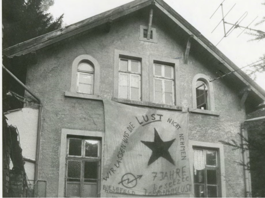
Besetztes Gebäude 1985 (Foto: Stadtarchiv Bielefeld)
